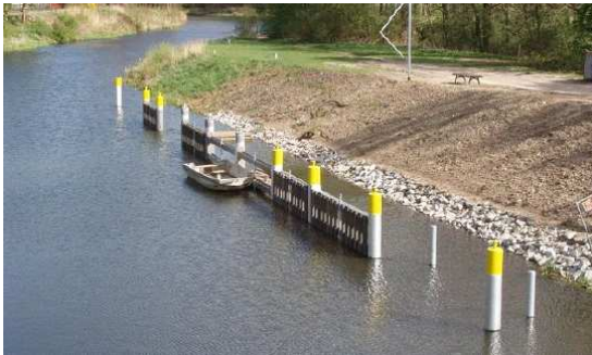
Abbildung 3: Neue Wartestelle im Wasser mit Steganbindung, Foto: Wasser- und Schifffahrtsamt Eberswalde
